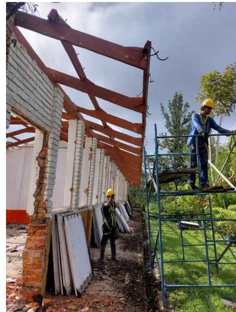
Ilustración 14: Desmonte de tejas onduladas y caballete. (Fuente propia)
