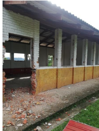
Ilustración 12: Desmonte puertas y ventanas. (Fuente propia)
