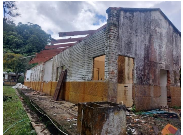
Ilustración 16: Desmonte de correas metálicas y/o madera. (Fuente propia)
