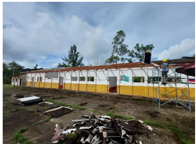
Ilustración 13: Desmonte de tejas onduladas de Eternit y caballete. (Fuente propia)
