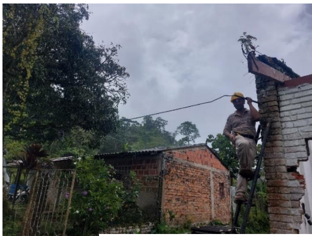
Ilustración 8: Desmonte y retiro de puntos eléctricos y lámparas existentes. (Fuente propia)
