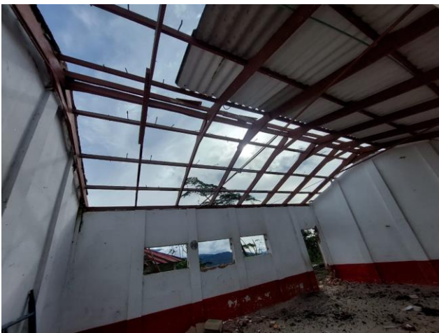
Ilustración 13: Desmonte de tejas onduladas de Eternit y caballete. (Fuente propia)
