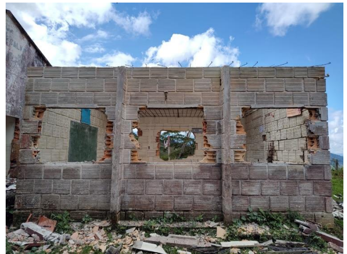
Ilustración 9: Desmonte de puertas y ventanas. (Fuente propia)
