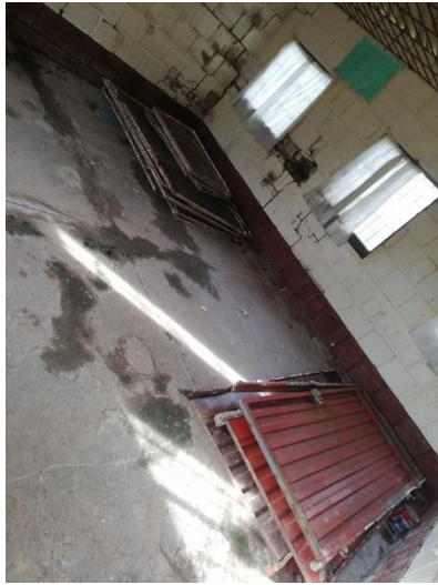
Ilustración 12: Desmonte puertas y ventanas. (Fuente propia)
