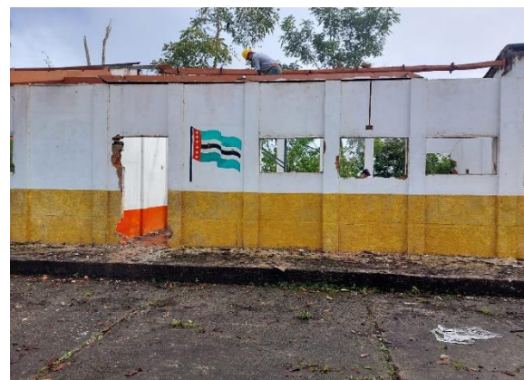
Ilustración 15: Desmonte de correas metálicas y/o de madera. (Fuente propia)
