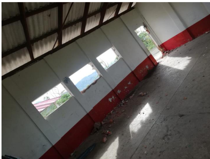
Ilustración 11: Desmonte puertas y ventanas. (Fuente propia)
