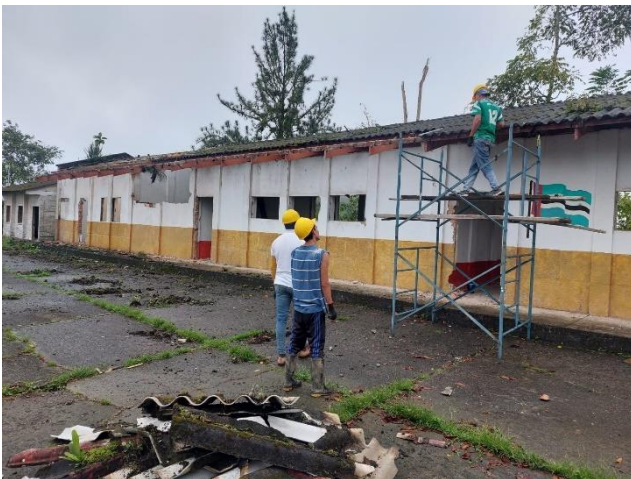
Ilustración 12: Desmonte puertas y ventanas. (Fuente propia)
