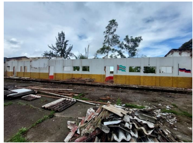
Ilustración 17: Desmonte de correas metálicas y/o madera. (Fuente propia)
