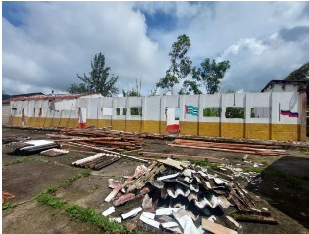
Ilustración 16: Desmonte de correas metálicas y/o madera. (Fuente propia)
