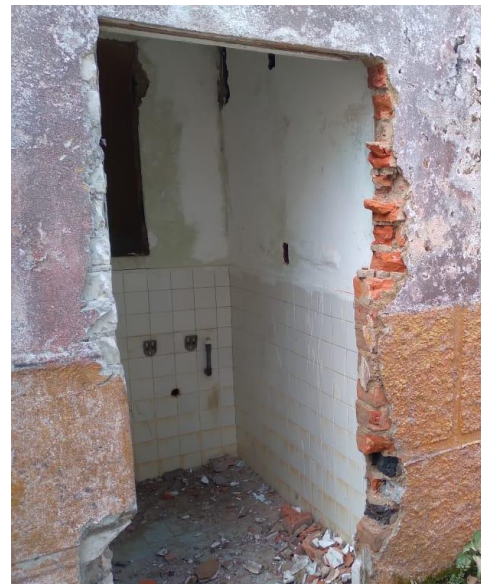
Ilustración 10: Desmonte y retiro de aparatos sanitarios, puntos hidrosanitarios y tuberías en PVC-S Y PVC-P. (Fuente propia)
