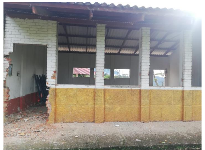
Ilustración 11: Desmonte puertas y ventanas. (Fuente propia)
