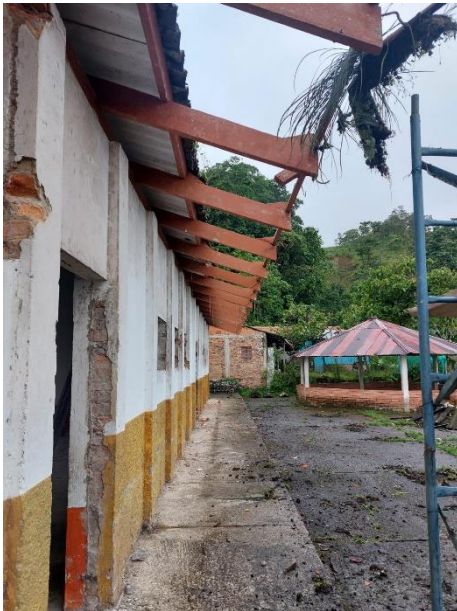
Ilustración 14: Desmonte de tejas onduladas y caballete. (Fuente propia)
